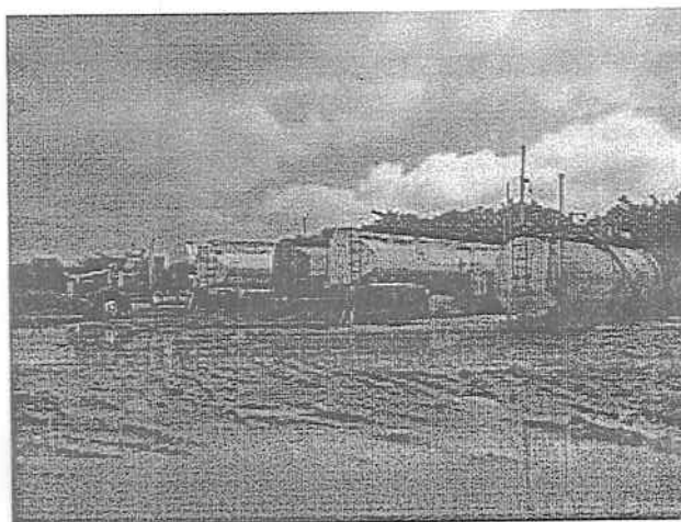
Foto 6. Cisternas en el predio para almacenamiento y transporte de aceite usado, ACPM y producto terminado
